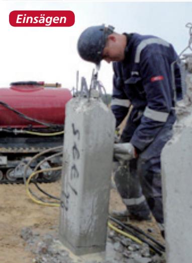
Mit Druckluft Löcher bohren
