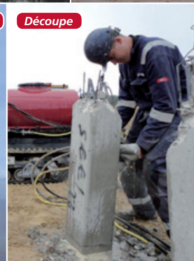
Forage pneumatique de trous
