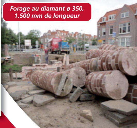
Démolition d'une annexe arrière
