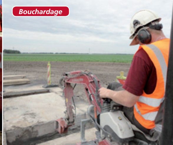
Forage pneumatique de trous
